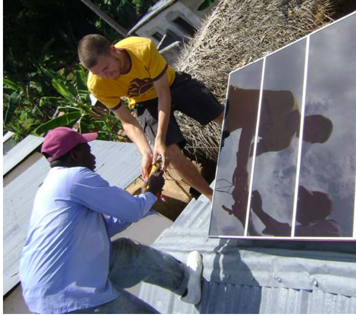
Abb 2: Installation auf Pemba
