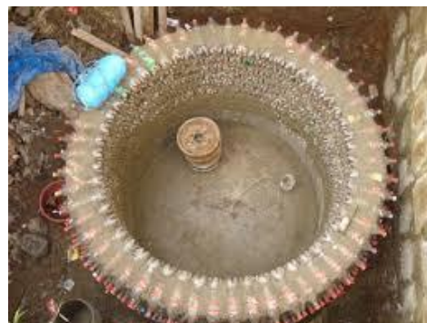
Recherche-Ergebnis möglicher Nutzungen von Plastikflaschen: mit Sand gefüllt zum Bau von Wasserlager-Tanks auf Sansibar
