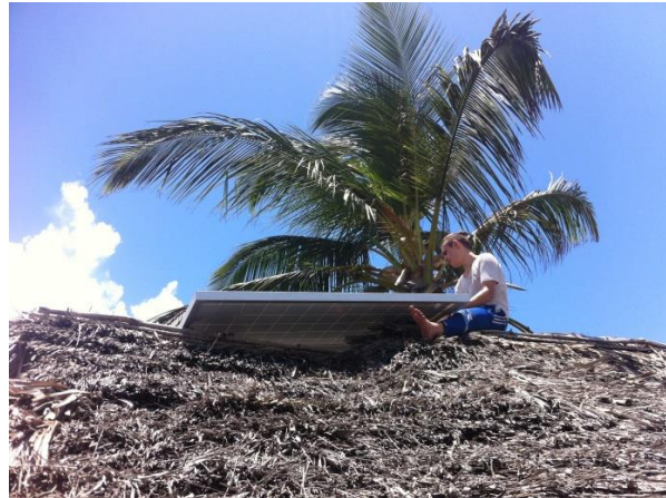
Installation eines SolarHomeSystems auf einem sansibarischen Haus
